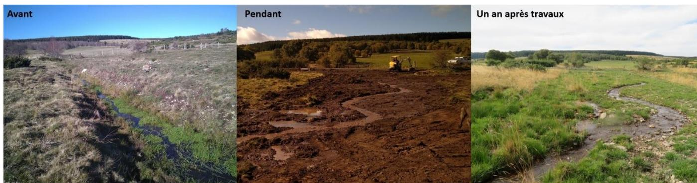
Exemple de travaux de réméandrage avant, pendant, après travaux (@CEN Auvergne, 2022)
