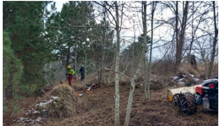
Chantier pédagogique (CEN Auvergne)
