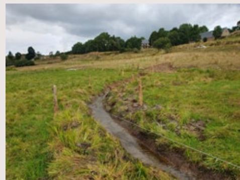
Travaux à Saint-Saturnin (CEN Auvergne)
