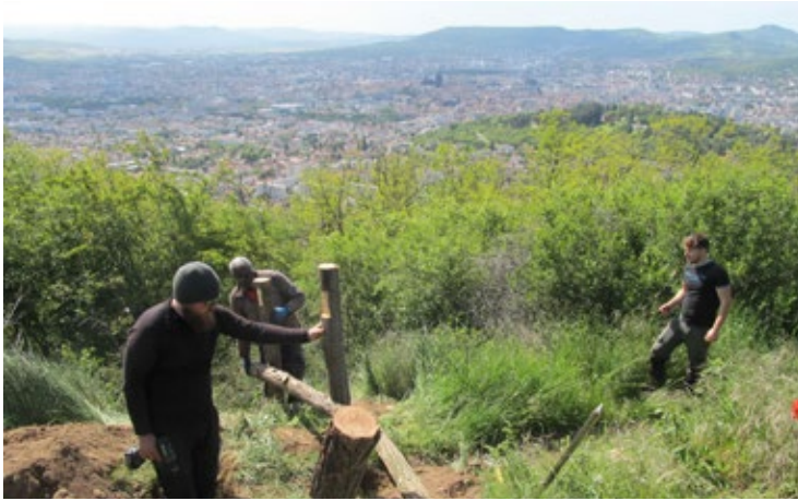
Installation de chicane (L. Le Corguillé)
