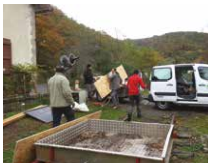
▲ Travaux de restauration à Saint-Illide
