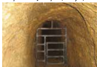
▼ Aqueduc de Jalenques (Mourjou)
