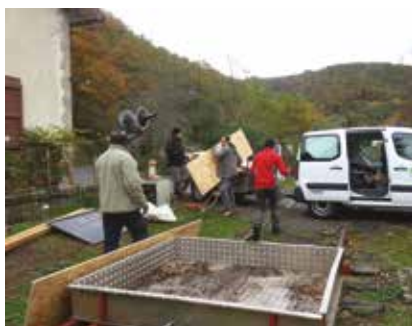
▲ Travaux de restauration à Saint-Illide
