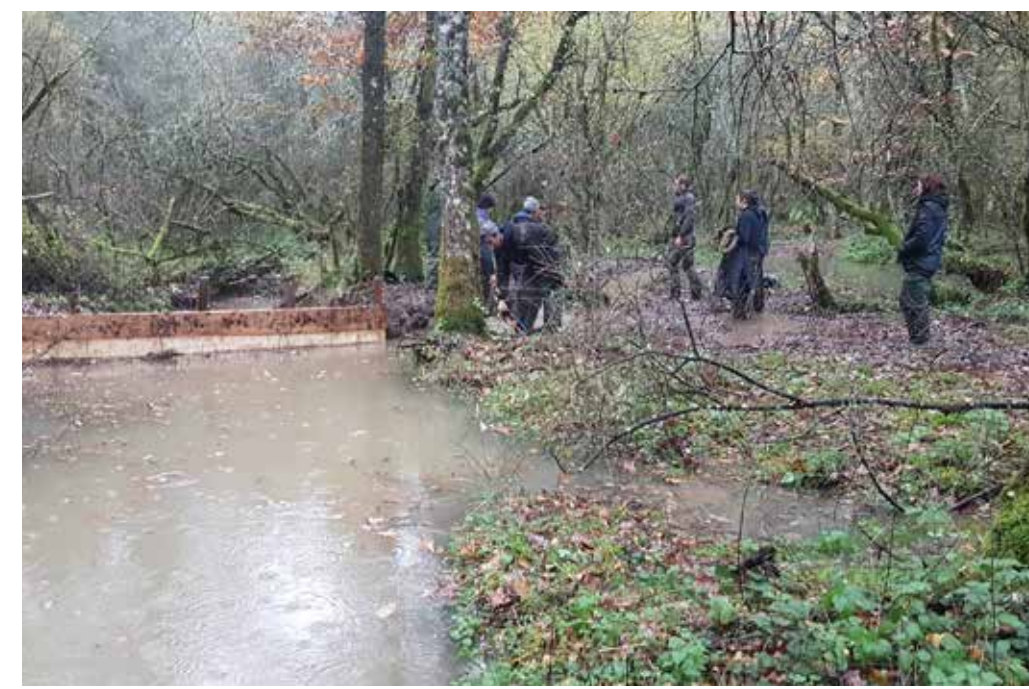
Comblement de fossés avec le lycée agricole d'Aurillac
