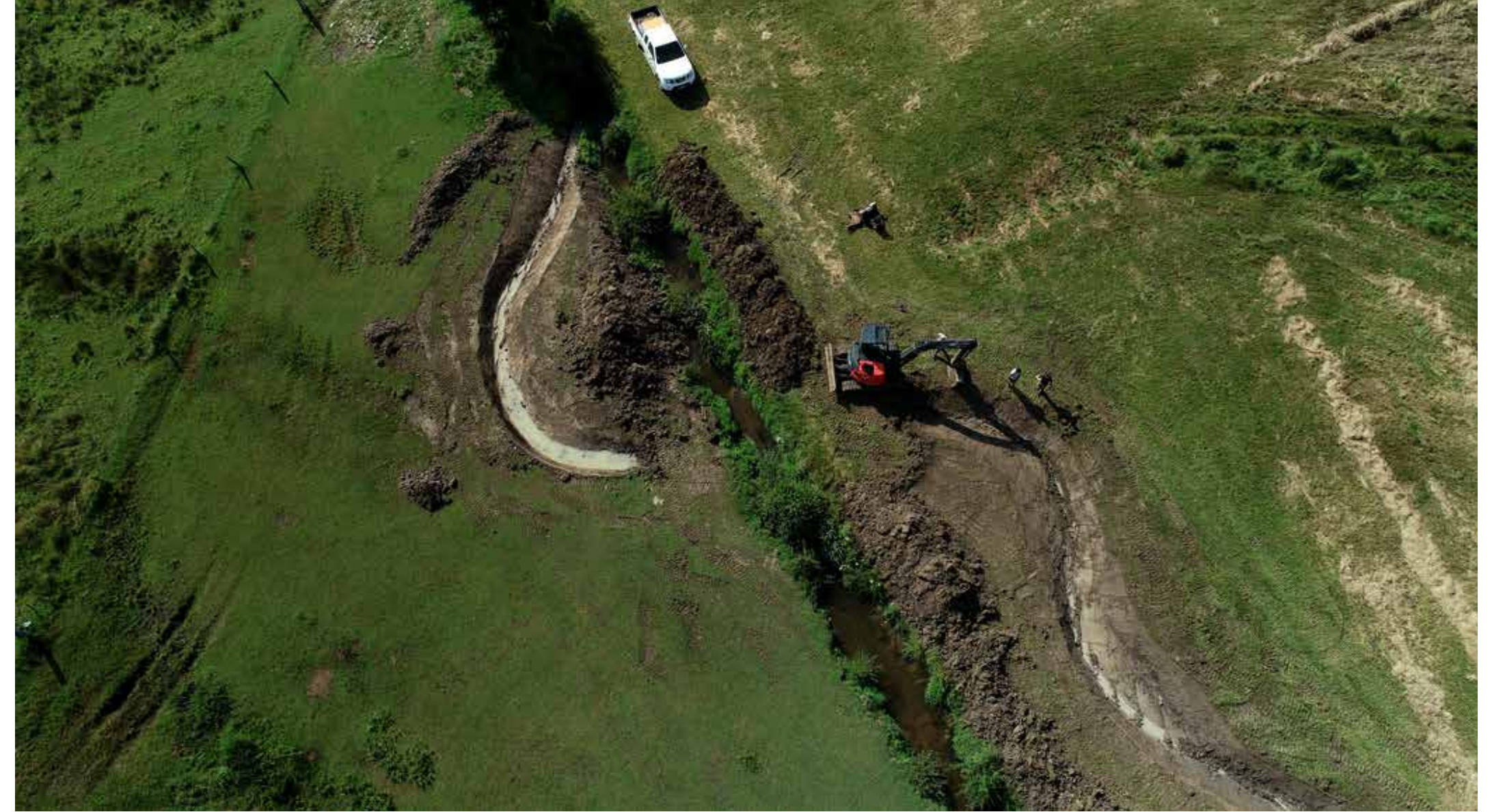
Réalisation de travaux de reméandrage
